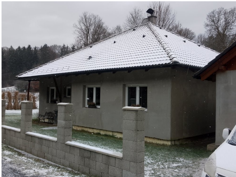
Oplocení pozemku bez výplní a vjezdových bran
