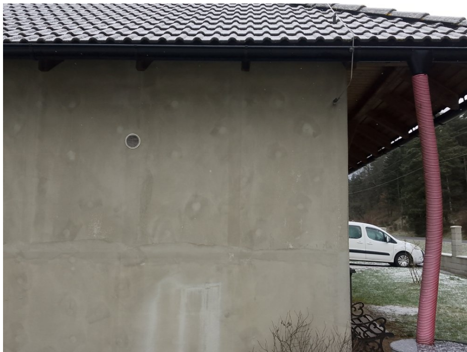
Chybějící svody
