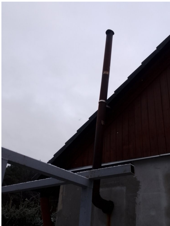
Stávající objekt SO 02 - vyústění kouřovodu
