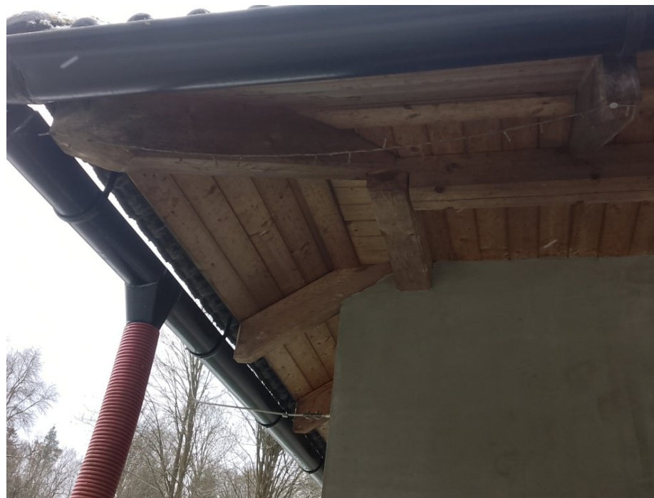
Chybějící svody
