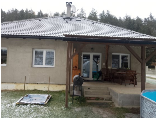
Plastové vstupní dveře a okna objektu...
