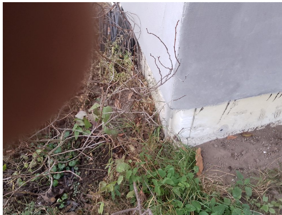
Objekt SO 01 - stávající fasáda a sokl
