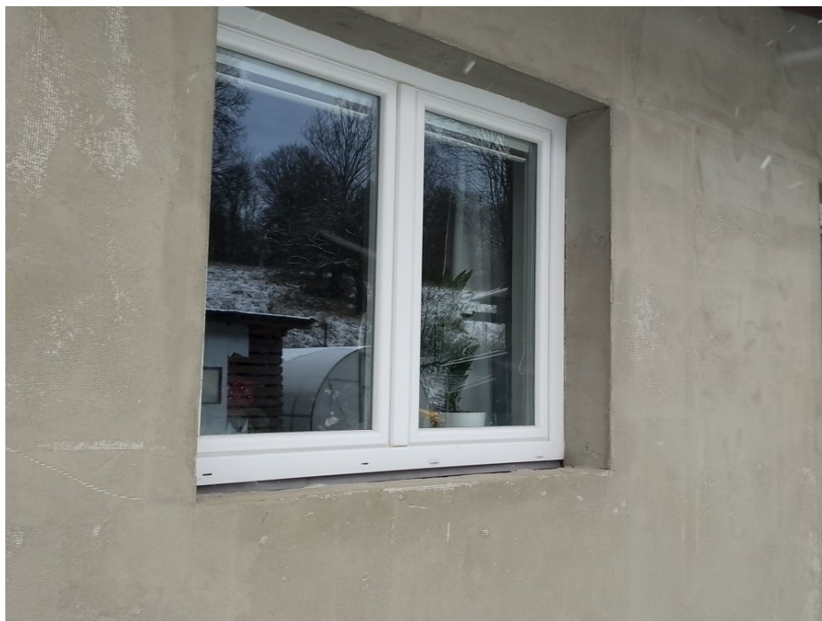
Klasické plastové okno objektu SO 01 bez parapetu
