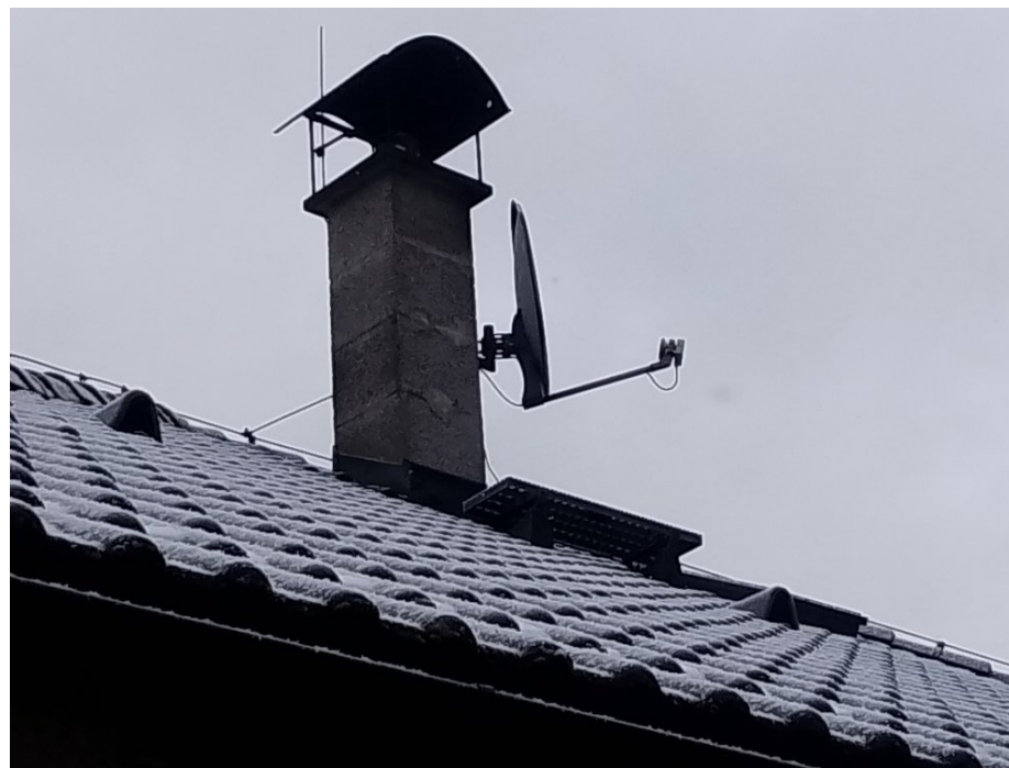
Stávající střecha nad SO 01
