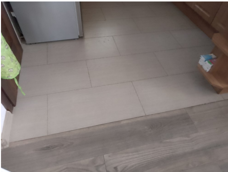
Podlahy v objektu SO 01 - keramická dlažba/plovoucí podlaha
